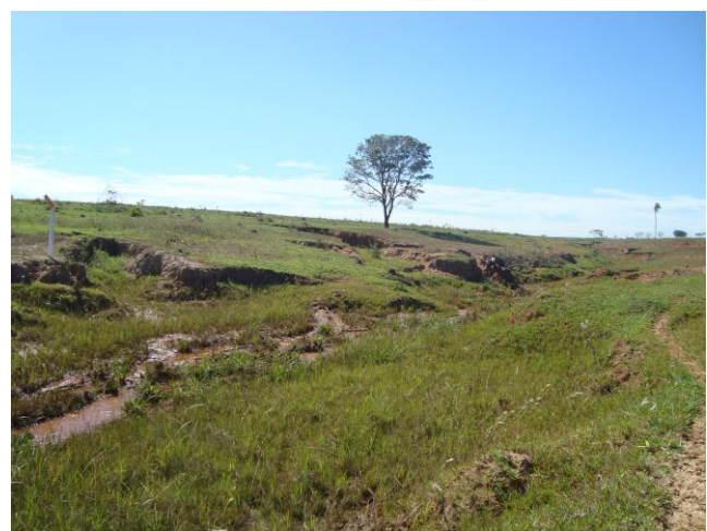
Foto 4 – Ponto de erosão P01.
