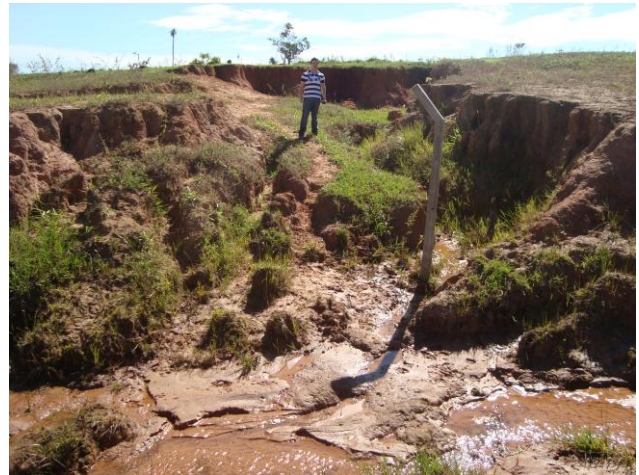
Foto 10 – Ponto de erosão P01.
