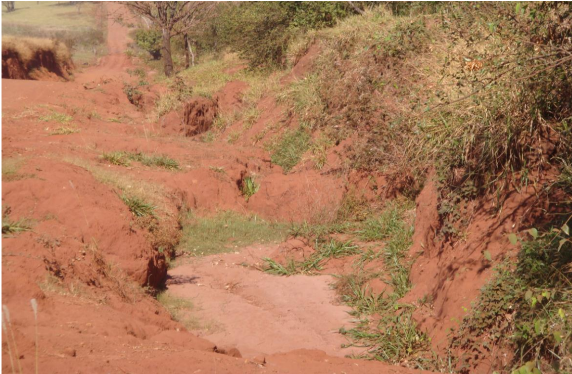
Figura 7.4 – Lateral de estrada funcionando como canal escoadouro com arraste intenso de partículas.
