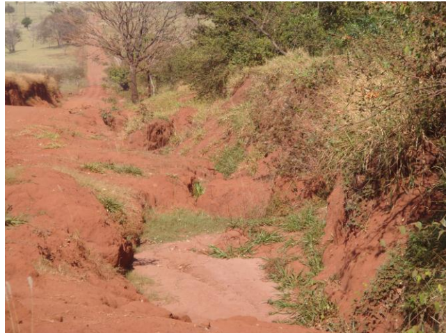
Foto 54 – Ponto de erosão P07.
