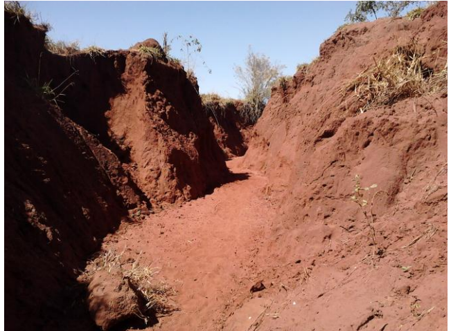
Foto 42 – Ponto de erosão P04.
