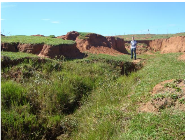
Foto 23 – Ponto de erosão P01.
