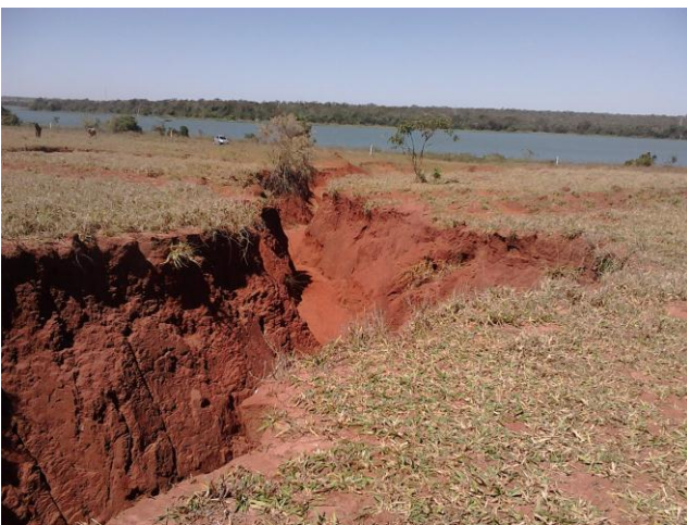
Foto 45 – Ponto de erosão P04.
