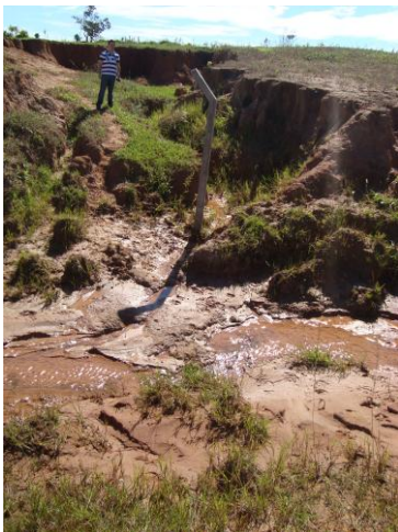
Foto 11 – Ponto de erosão P01.
