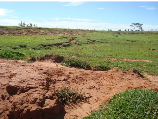
Foto 17 – Ponto de erosão P01.
