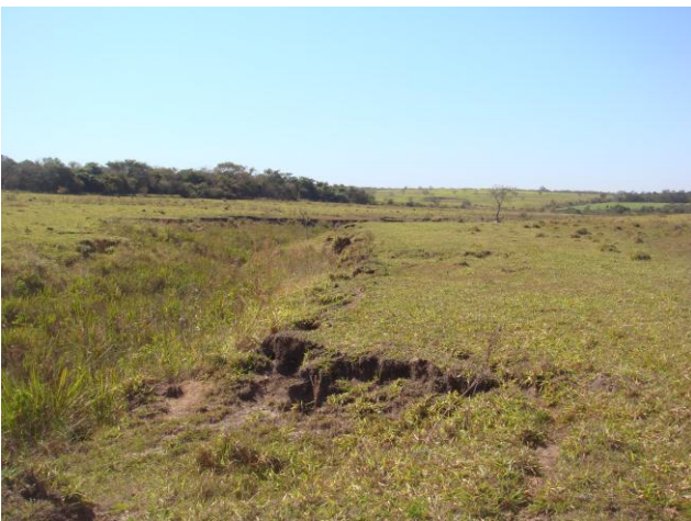
Foto 59 – Ponto de erosão P09.
