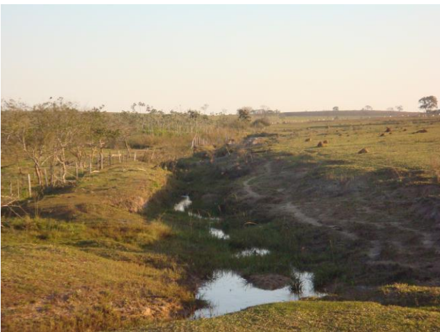
Foto 47 – Ponto de erosão P05.
