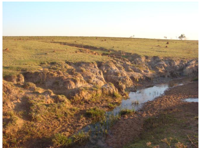
Foto 36 – Ponto de erosão P03.
