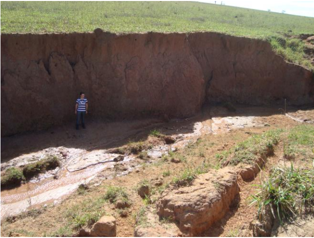
Foto 31 – Ponto de erosão P02.
