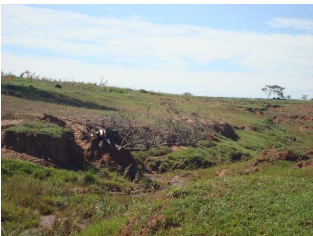
Foto 5 – Ponto de erosão P01.
