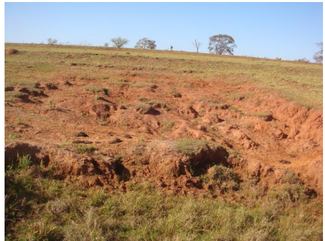
Foto 50 – Ponto de erosão P06.
