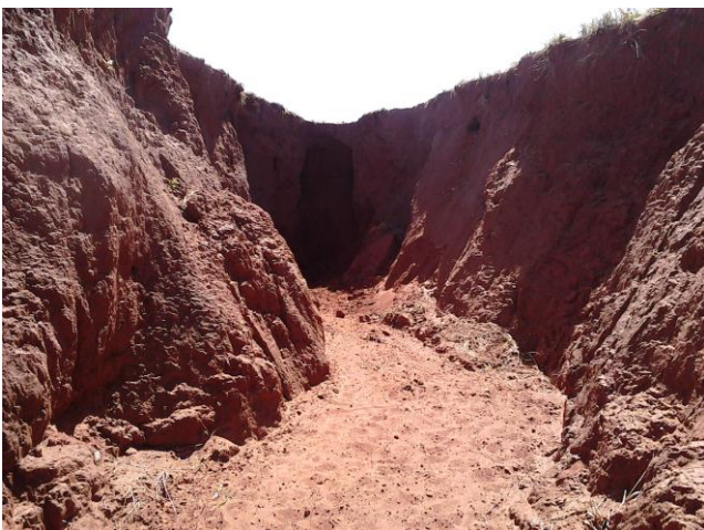
Foto 41 – Ponto de erosão P04.
